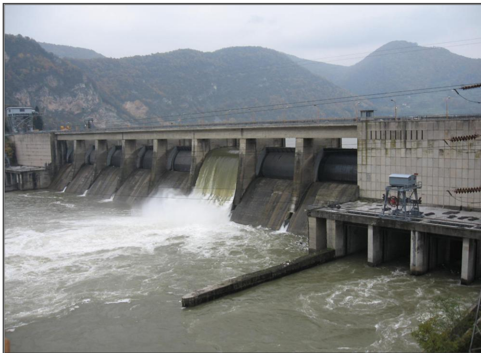
Fotografija 3: Brana Zvorničke akumulacije
