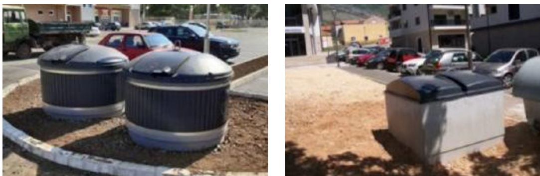
Слика 4.1. Полуподземни и подземни контејнери
